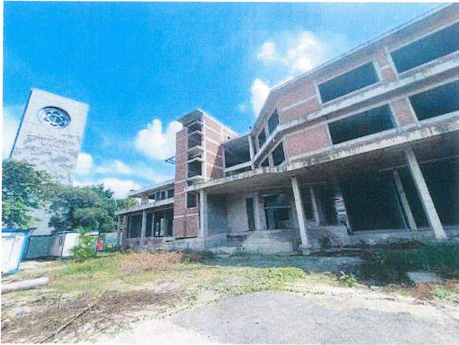
ภาพแสดงโครงการที่ก่อสร้างยังไม่แล้วเสร็จในปัจจุบัน
