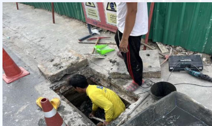
การลอกท่อ บ่อดักตะกอนรอบโครงการ
