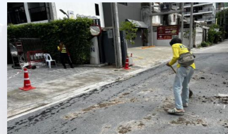
ทำความสะอาดพื้นที่ก่อสร้าง และถนน
