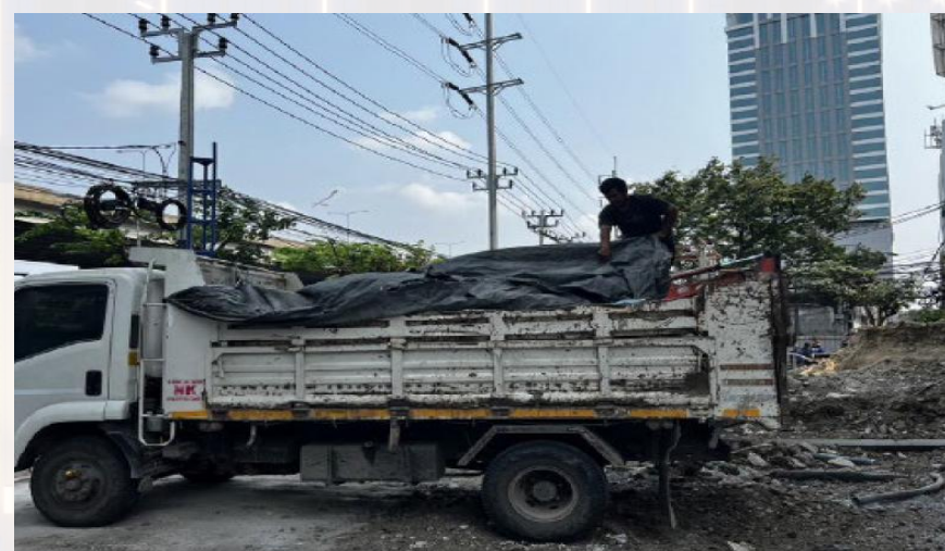
การขนย้ายขยะจากการก่อสร้าง
